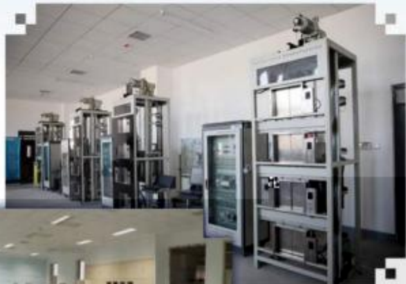
智能电梯安装调试维护训练场所
